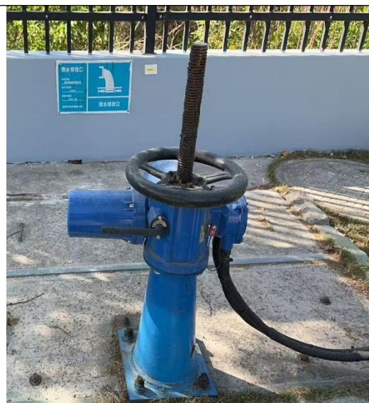
雨水排口及标识牌
