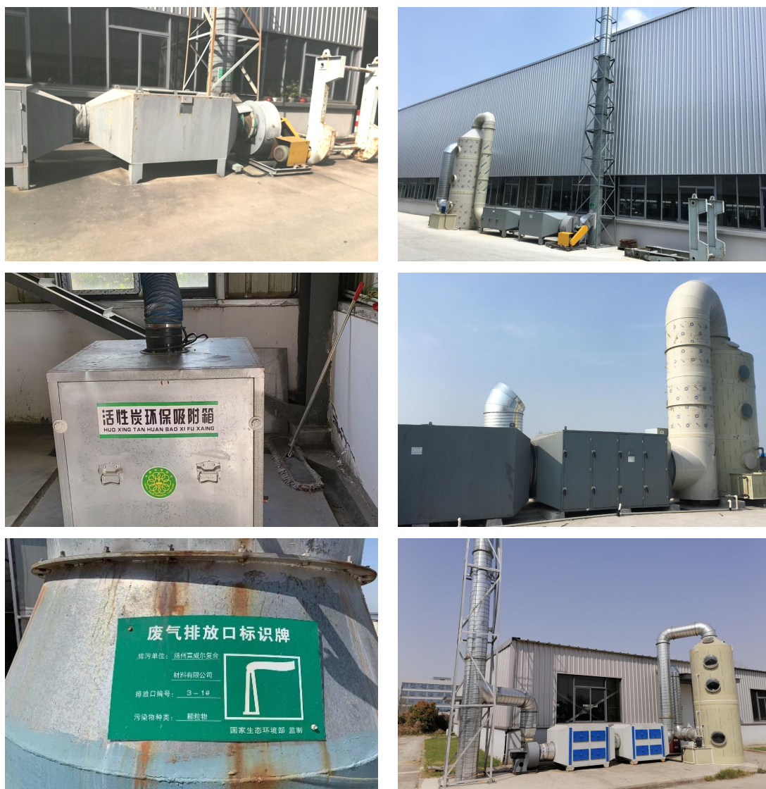
图 3-2 废气处理装置及环保标志牌
