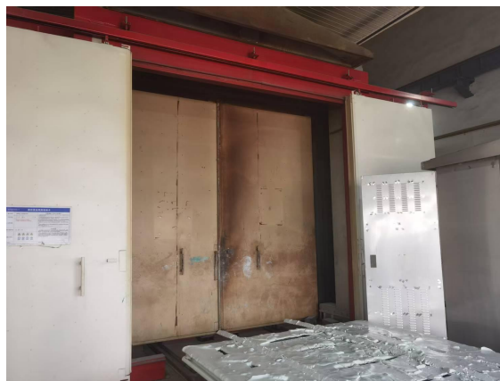
图 3-3 厂区喷漆房已封闭停用
