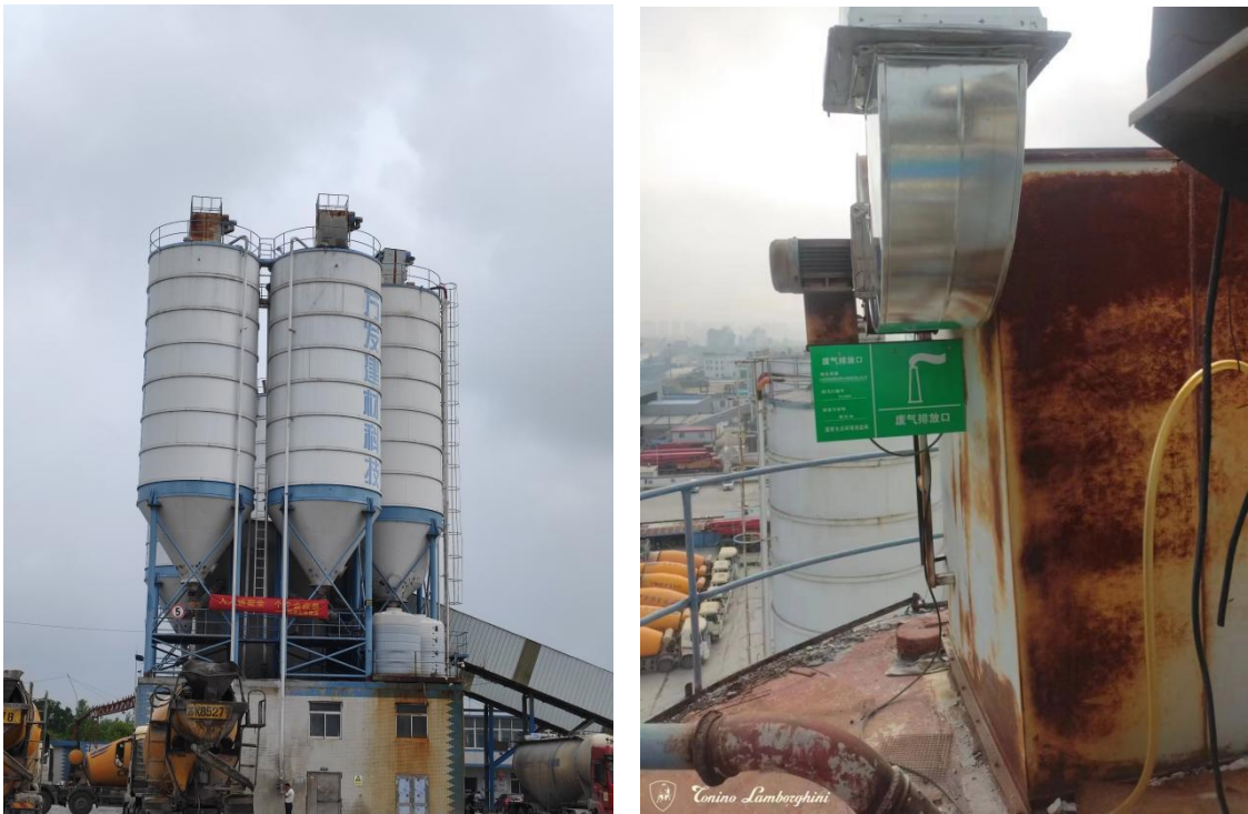
图 3-3 废气处理装置及排气筒标识标牌
