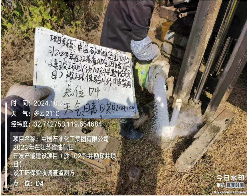
沙102地下水监测现场打井照片
