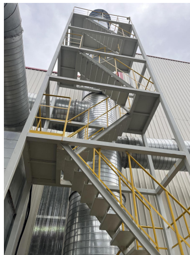
新厂房批****、晾干、****打磨、喷涂废气密闭收集+布袋除尘器+过滤棉+ 水喷淋+二级活性炭吸附装置+DA003 排气筒
