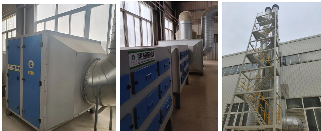
老厂房批****、晾干、喷涂废气密闭收集+过滤棉+水喷淋+ 二级活性炭吸附装置+DA002 排气筒
