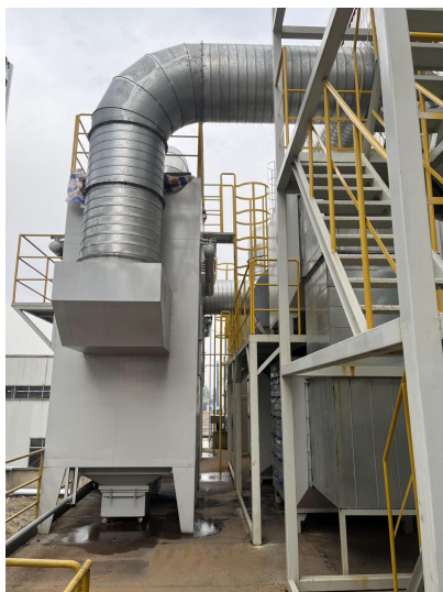
新厂房批****、晾干、****打磨、喷涂废气密闭收集+布袋除尘器+过滤棉+ 水喷淋+二级活性炭吸附装置+DA003 排气筒
