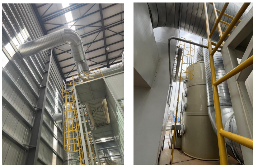
老厂房批****、晾干、喷涂废气密闭收集+过滤棉+水喷淋+ 二级活性炭吸附装置+DA002 排气筒
