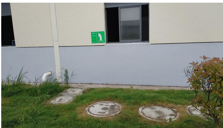
图 3-1 厂区污水接管口
