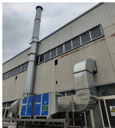
有机废气收集管道装置+二级活性炭装置+DA001 排气筒
