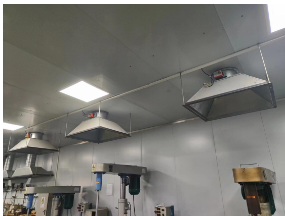
有机废气收集管道装置+二级活性炭装置+DA001 排气筒
