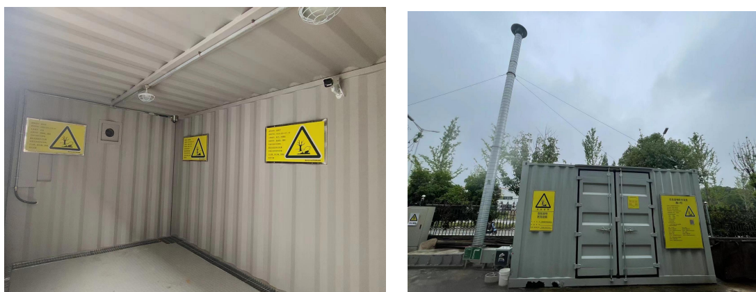
有机废气收集管道装置+二级活性炭装置+DA003 排气筒
