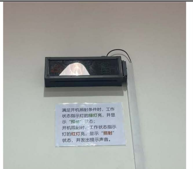
探伤室内照射状态指示装置及说明
