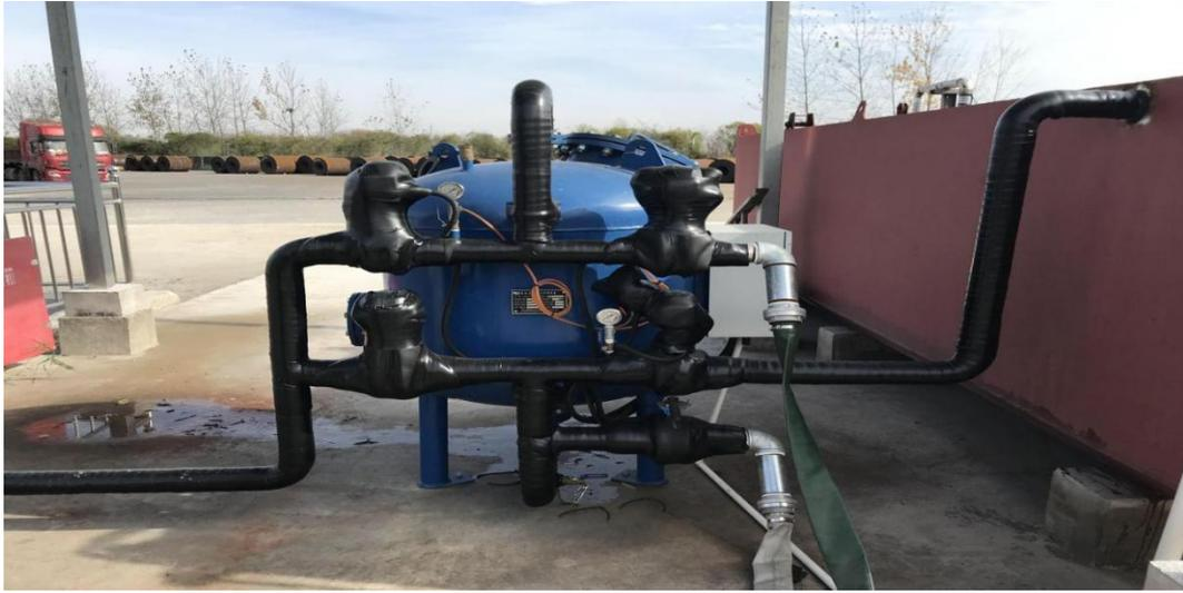
图 5-8 浅层石英砂过滤器
