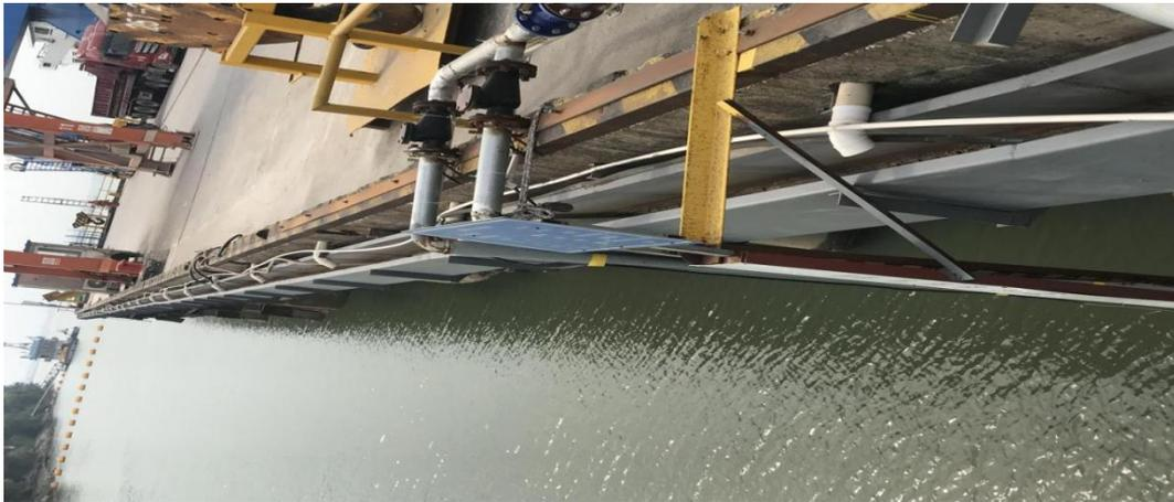
图 5-5 抑尘废水及雨水收集措施
