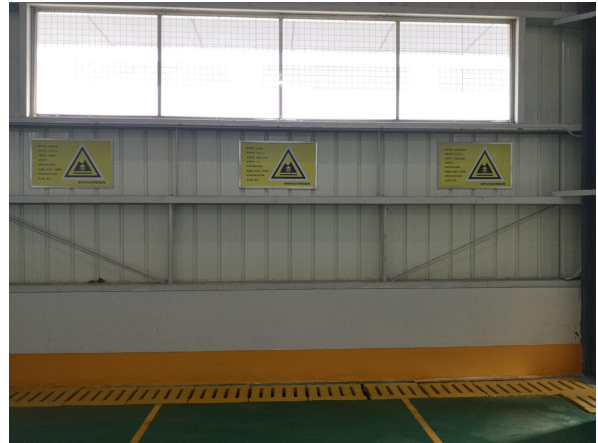
危废库内部分区及导流槽
