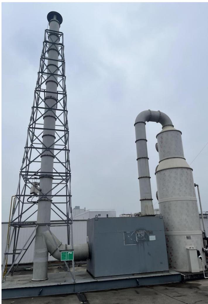
图 3-3 废气处理装置及排气筒标识标牌<sup>[1]</sup>
