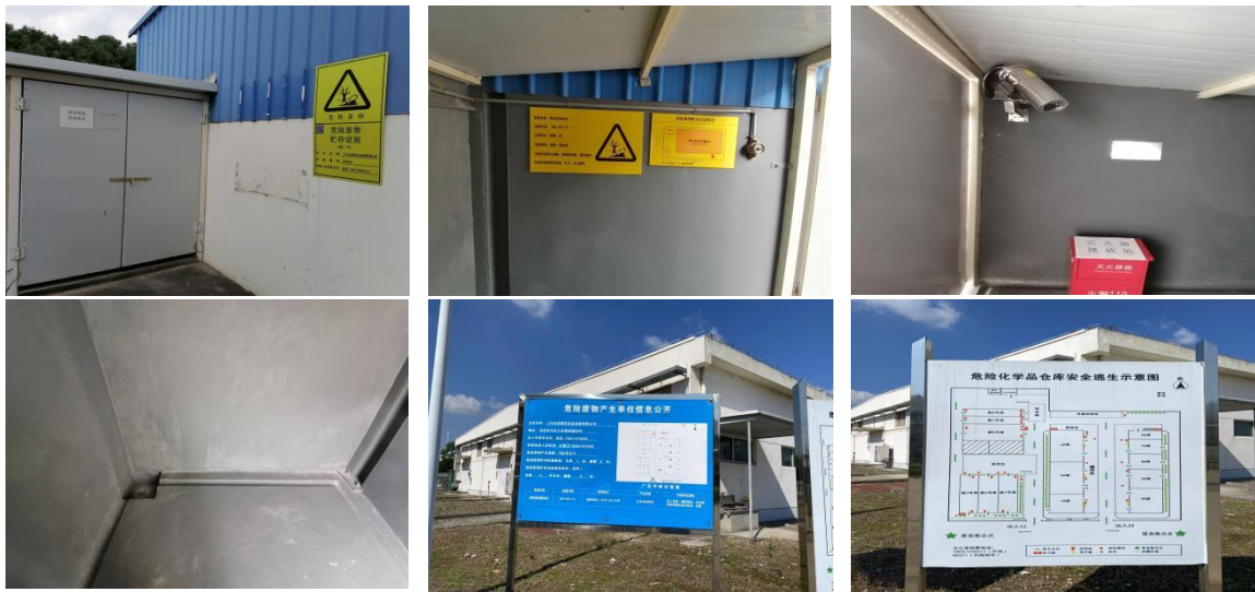
图 3-1 厂区危废库现状图
