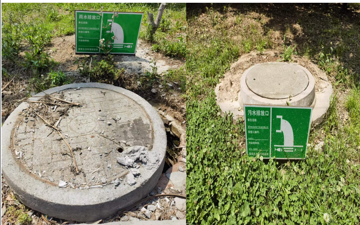
图 3-4 本项目雨污水外排口
