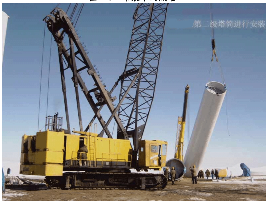
图 2-6-2 安装中的第二级塔筒
