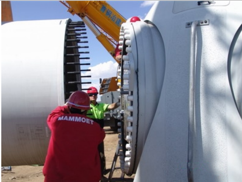
图 2-6-3 安装中的叶片
