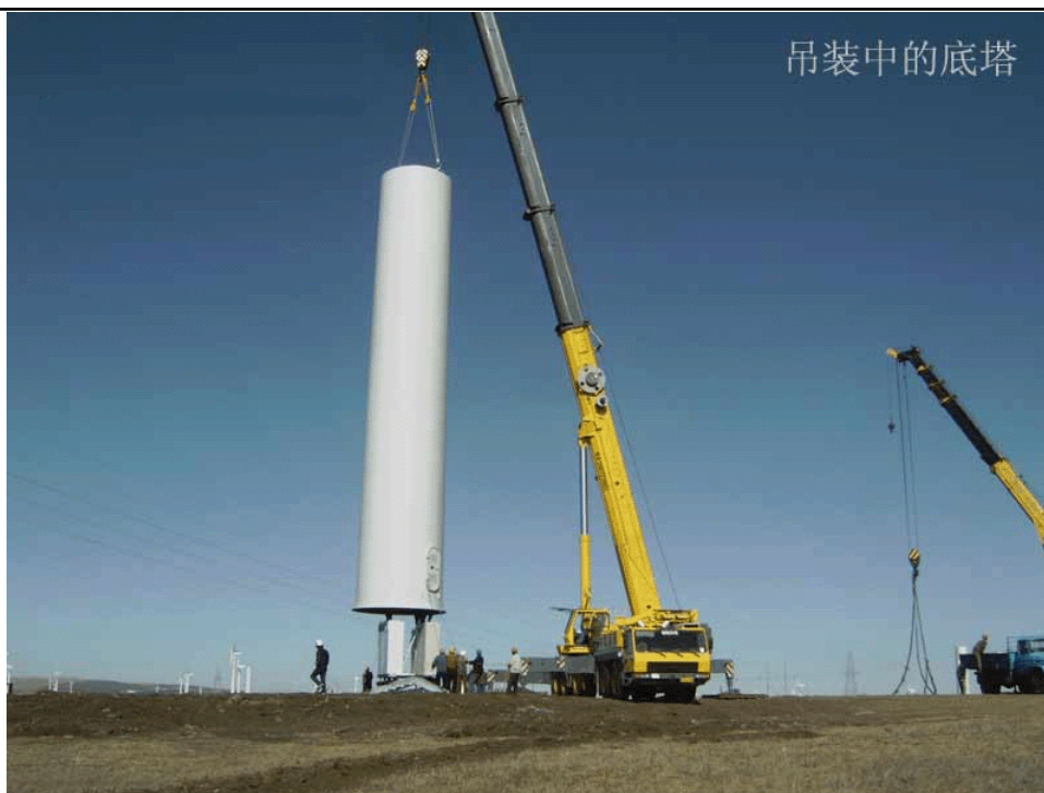
图 2-6-1 吊装中的底塔
