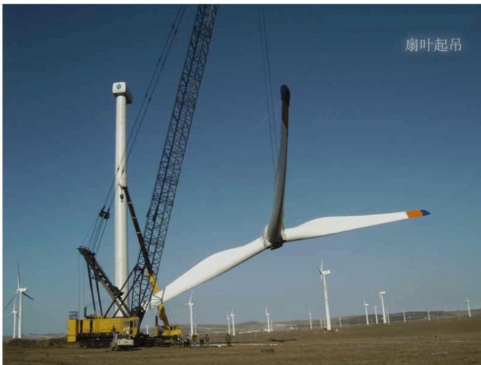
图 2-6-4 吊装中的叶片
