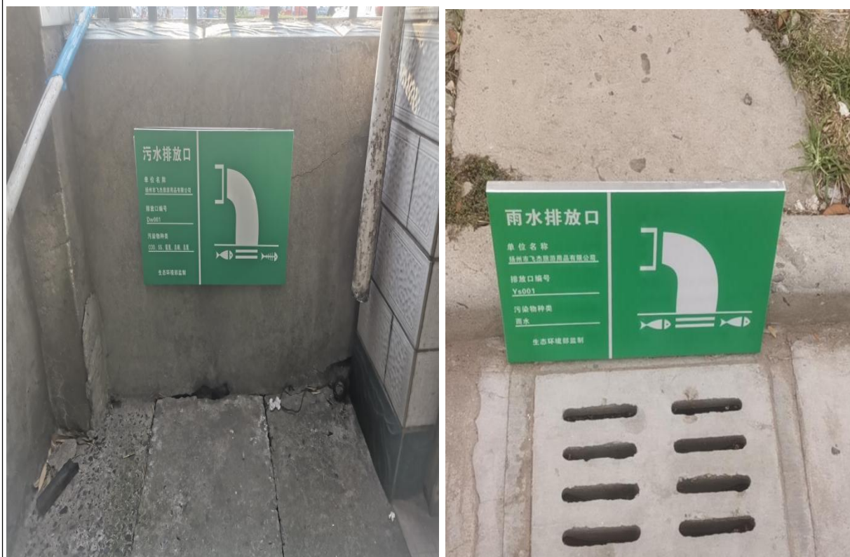
图3-3 雨污水排放口及环保标识牌
