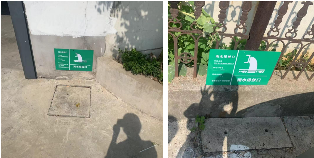
图3-2 厂区污水及雨水排放口
