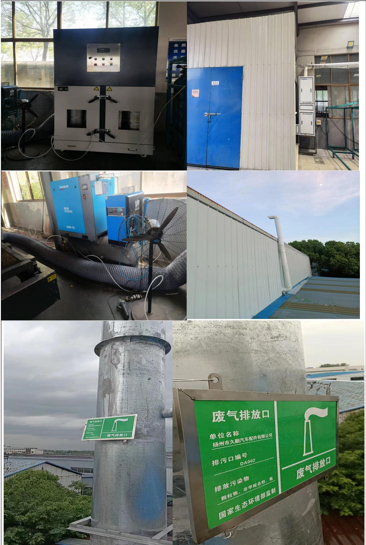
图 3-2 废气处理装置及环保标志牌
