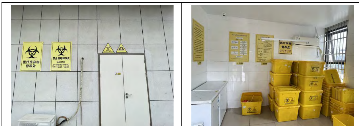
图 4-11 医疗废品暂存间
