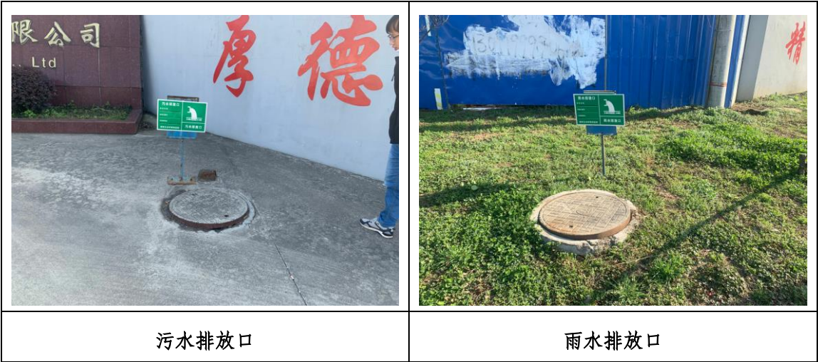
图3-1 厂区污水及雨水排放口
