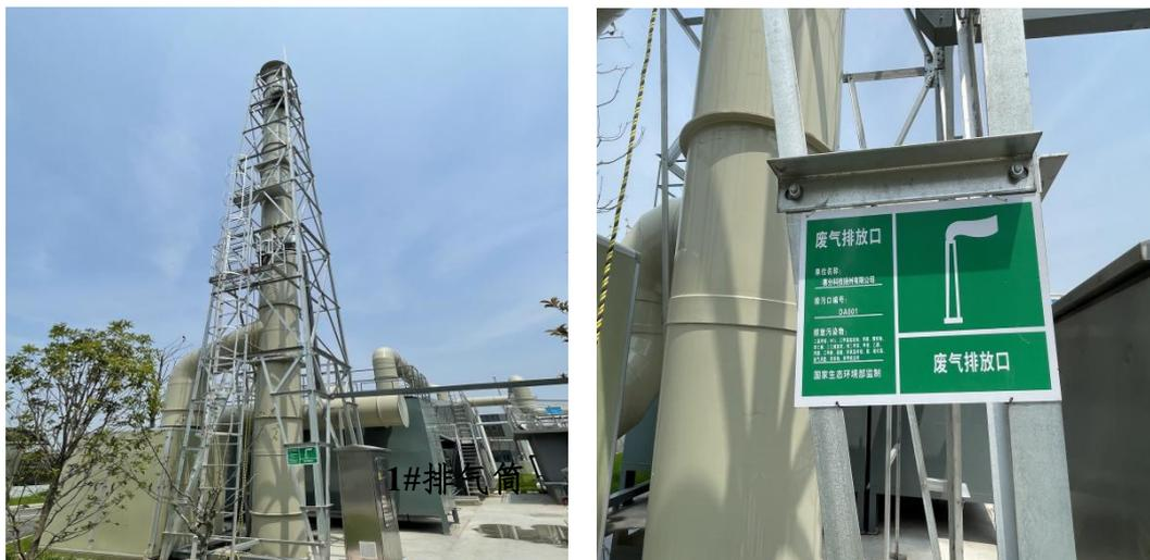
图 3-5 废气处理装置及排气筒标识标牌<sup>[1]</sup>
