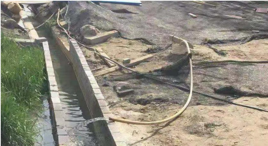
图 3-1 施工期废水收集及回用措施
