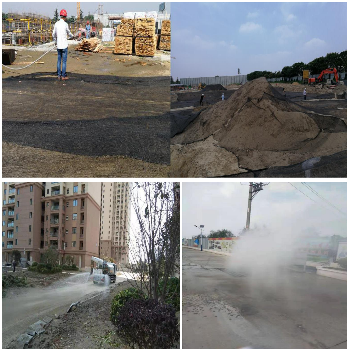
图 3-3 施工期扬尘防治措施
