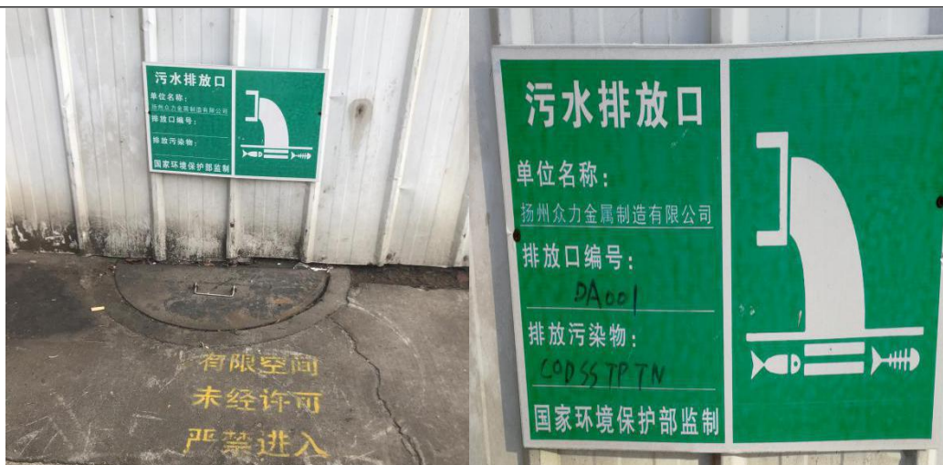
图 3-2 厂区污水排口及标识标牌
