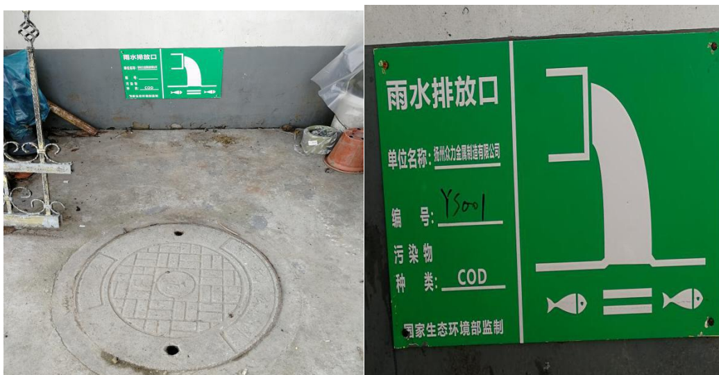
图3-3 厂区雨水排口及标识标牌
