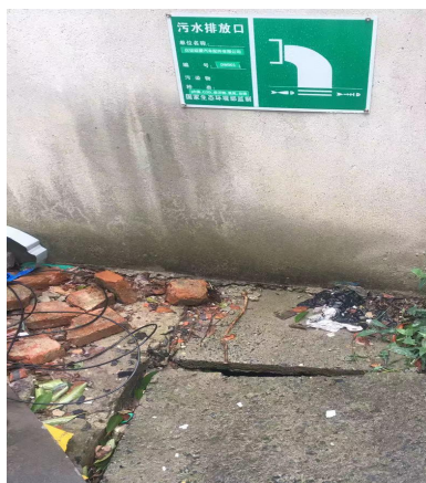
图3-2 污水接管口标识牌
