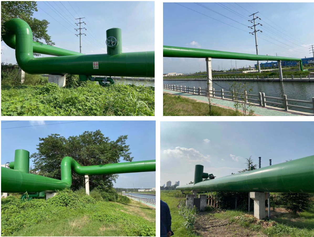
图 4-4 本项目营运期现场图
