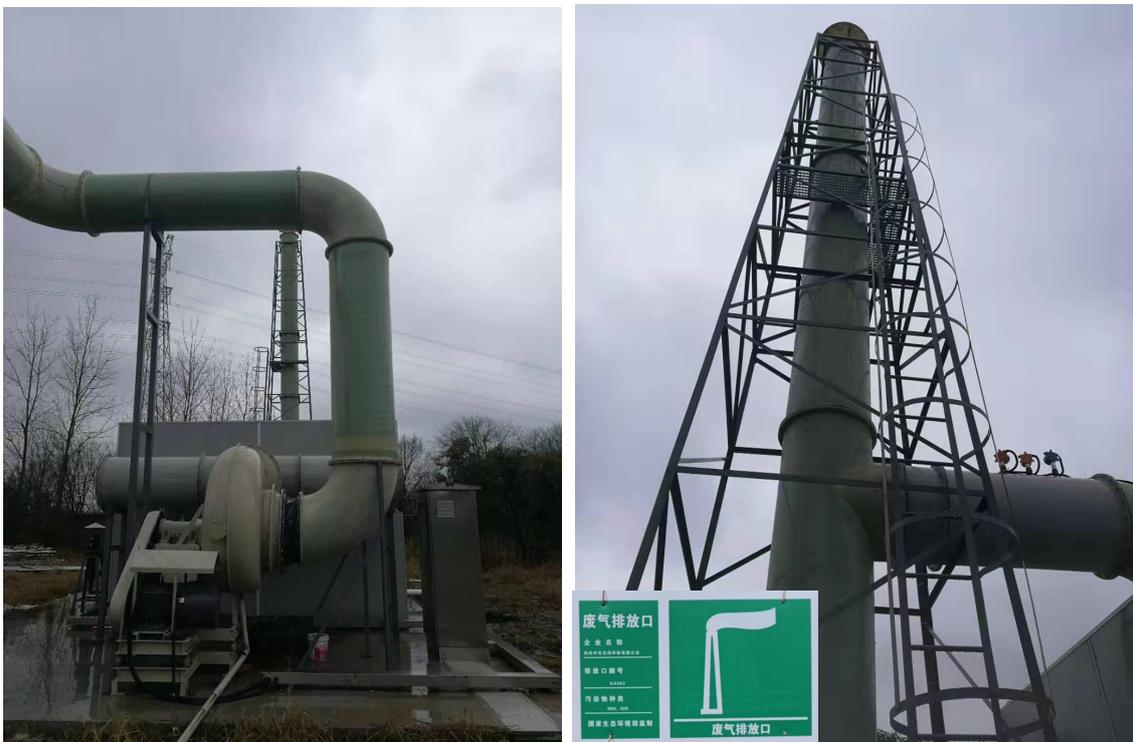
图 3-3 污水池废气处理装置及排气筒
