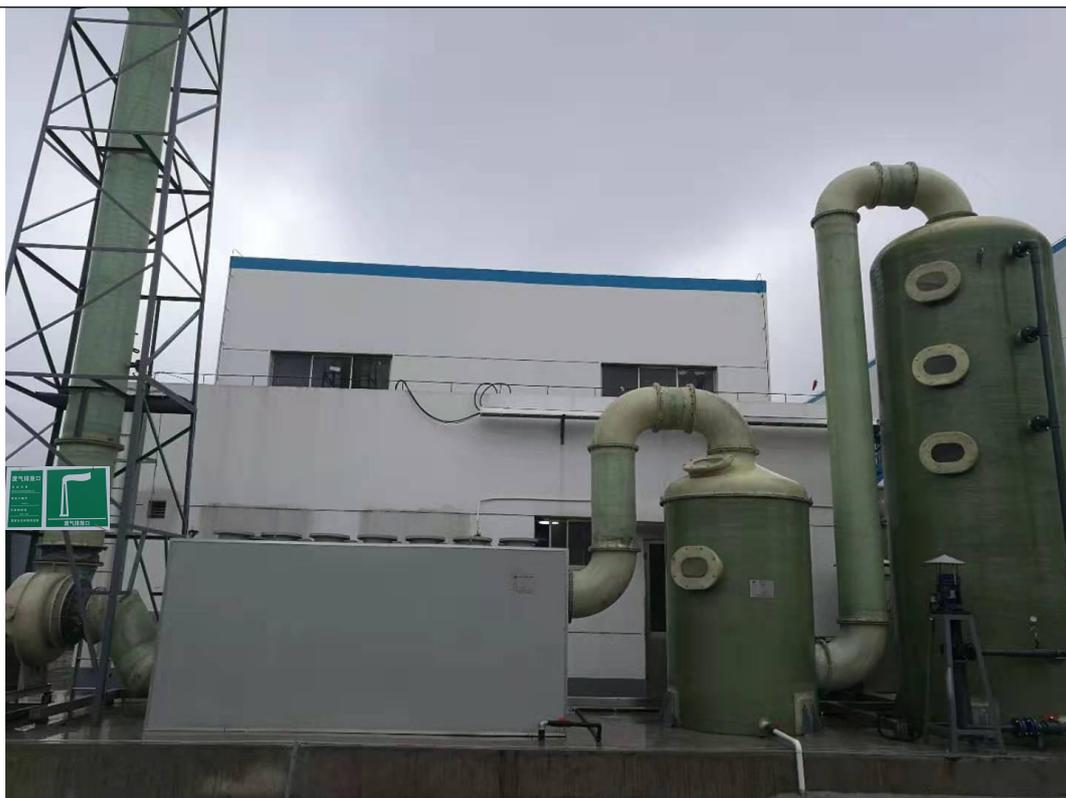
图 3-4 污泥浓缩废气处理装置
