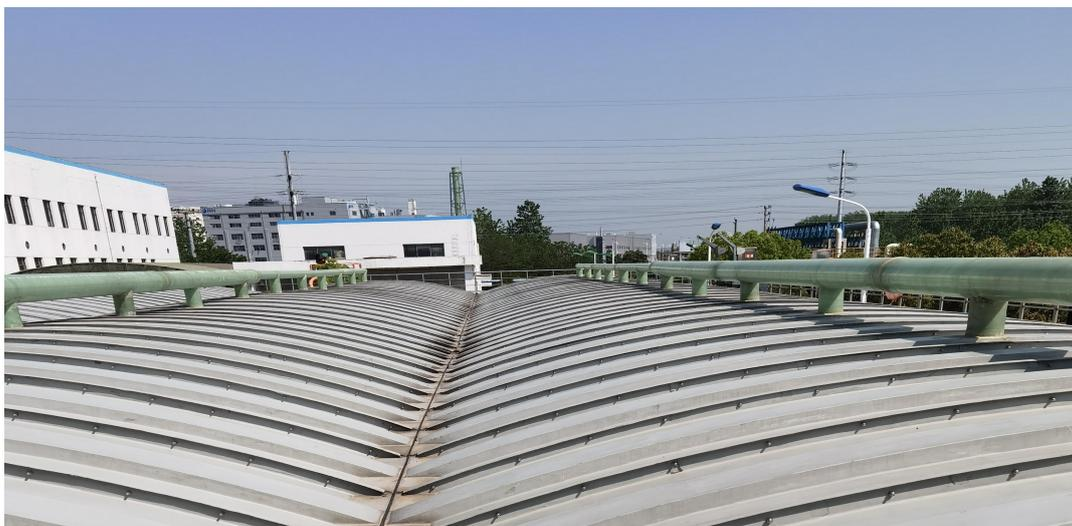
图 3-5 污水池废气加盖收集
