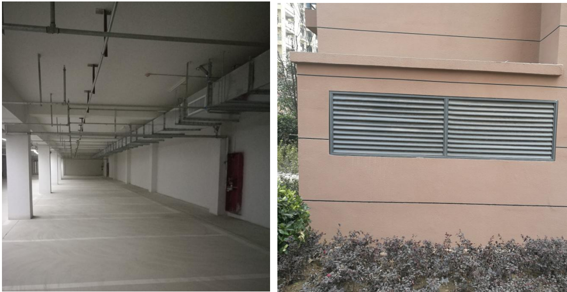
图 3-4 地下车库排风系统及排风口
