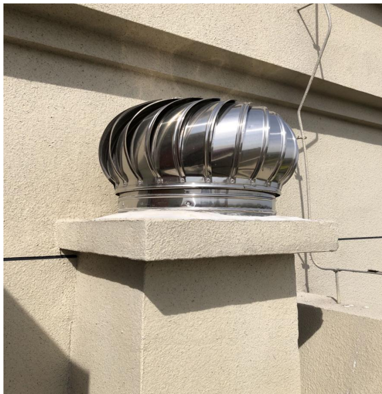
图 3-4 地下车库排风系统及排风口
