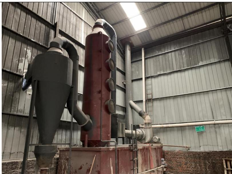
图 3-4 1#排气筒及除尘装置
