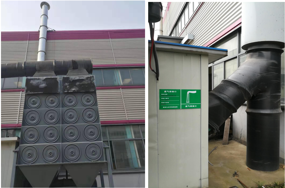
图 4-6 打磨废气处理装置及排气筒标识
