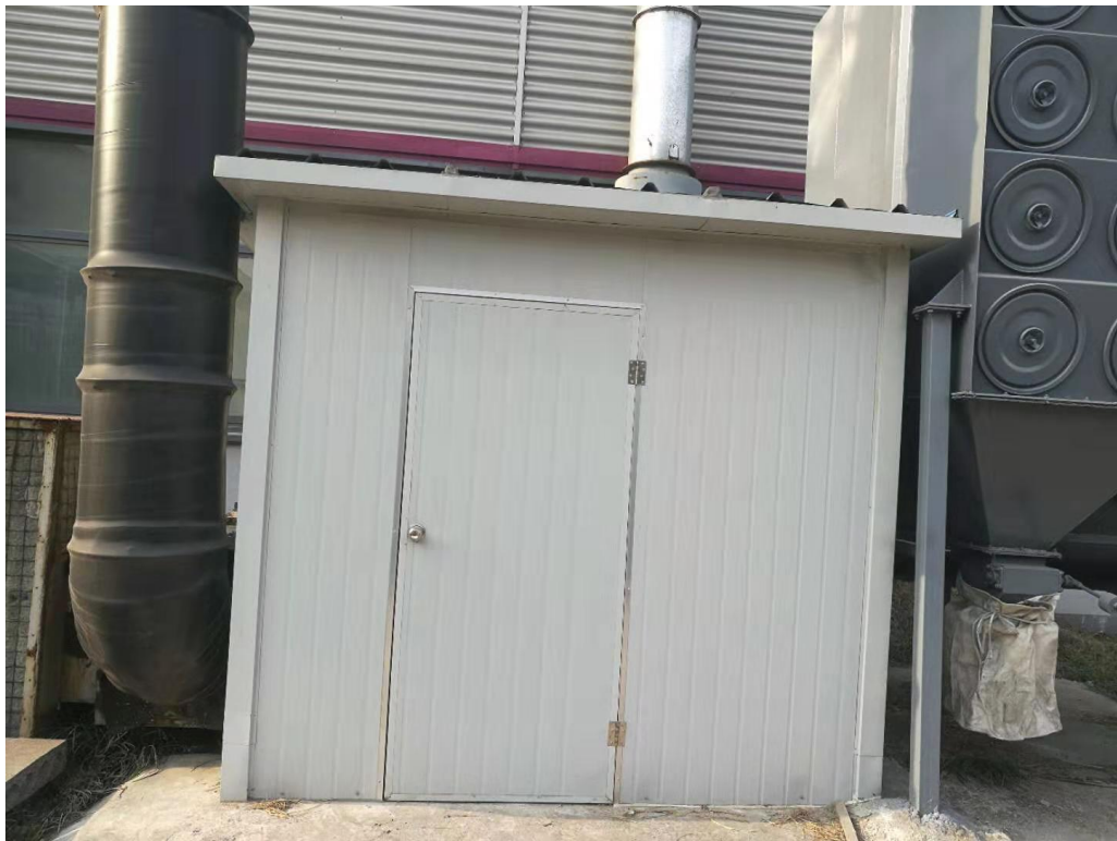
图4-9 噪声防治措施（风机隔音房）
