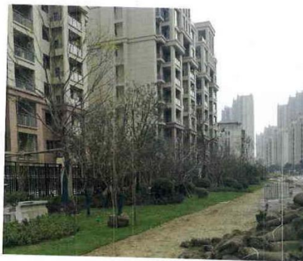
图 3-3 小区雨水排放口方位
