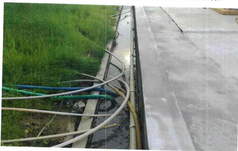
图 3-1 施工期废水收集及回用措施
