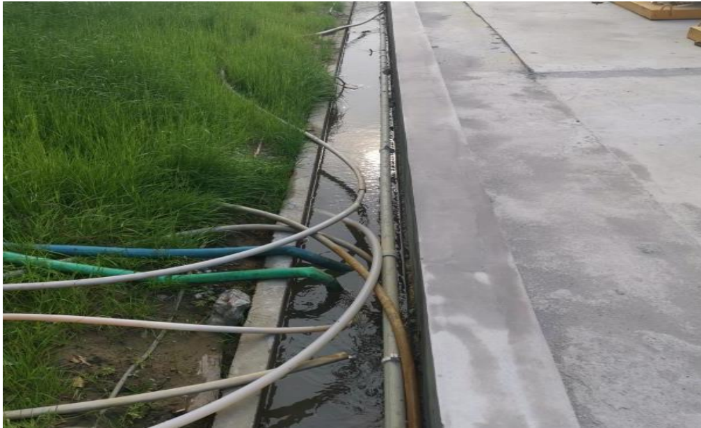
图 3-1 施工期废水收集及回用措施
