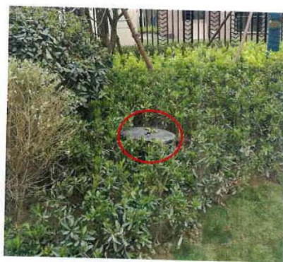
图 3-4 A 区废水接出口位置
