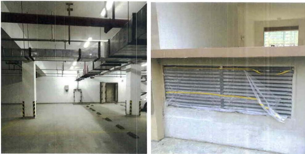
图 4-8 地下机械排风系统及排风口
