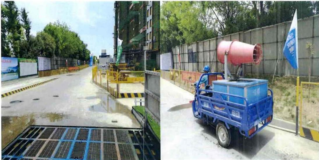
图 4-6 进出车辆清洗及洒水降尘
