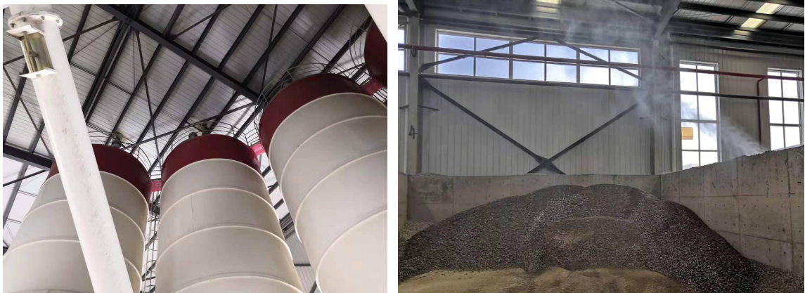
图 3-4 袋式除尘装置及喷雾降尘
