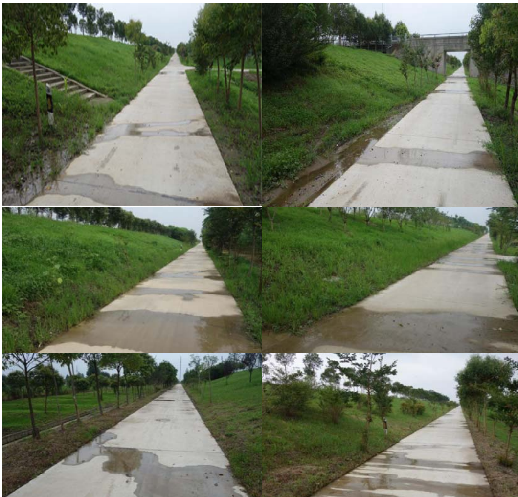
图 1-1 西堤窖潮位置现场情况
