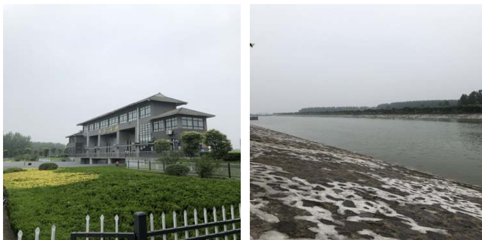
图 1-3 抛石防护位置现场情况
