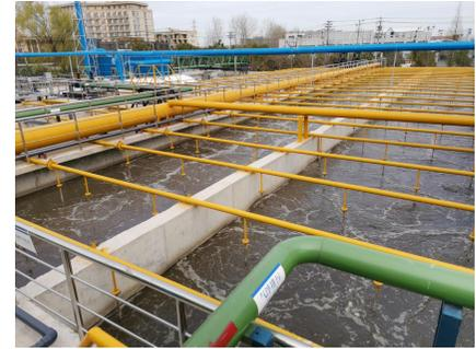
图 9 废水站接触氧化池
