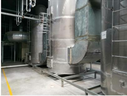
图 1 定型废气处理装置
