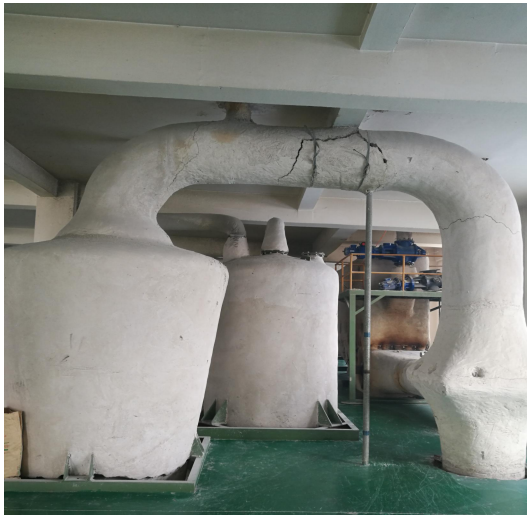
图 10-1 旋风除尘装置
